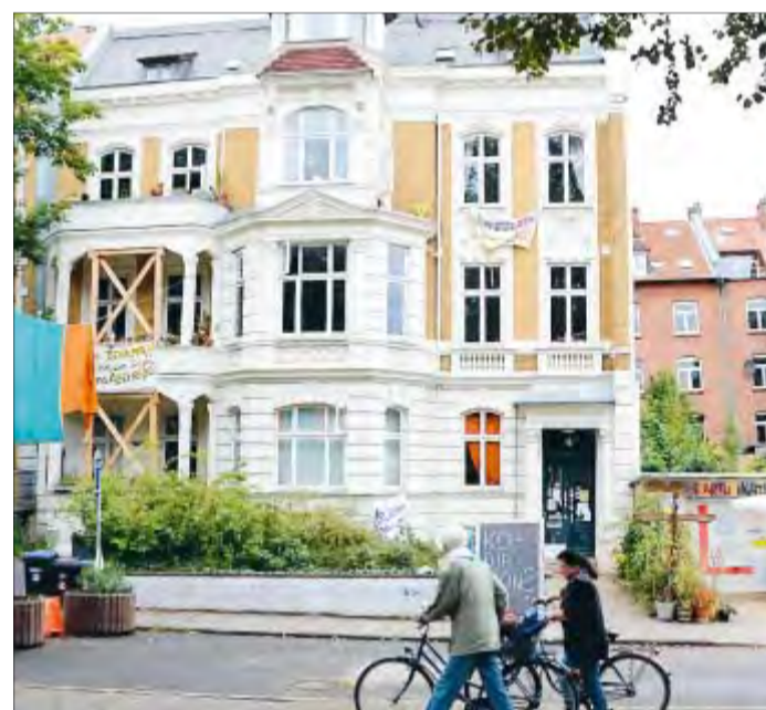
Die Bewohner der Frommestraße 4 müssen nun bis zum 11. November das Haus verlassen haben. Foto: be
